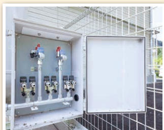
ユニットのフタを開けると10口のガス栓が備えられている。
